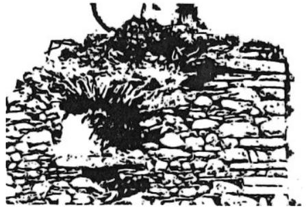
*Stark einsturzgefährdete Fensterpartie der Burg Splügen. Das Wurzelwerk auf dieser Mauerecke hat den Eckstein aus dem Verband geschoben und den Mauermantel über dem Fensterbogen weggesprengt. 5)*
