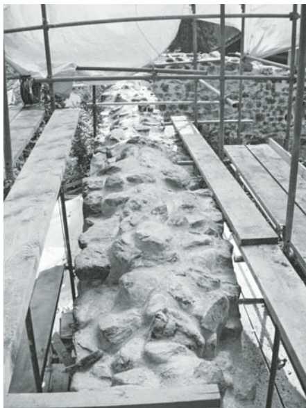
Die 2008 gesicherte Mauerkrone der Nordwand von Strahlegg (Foto BVG)
