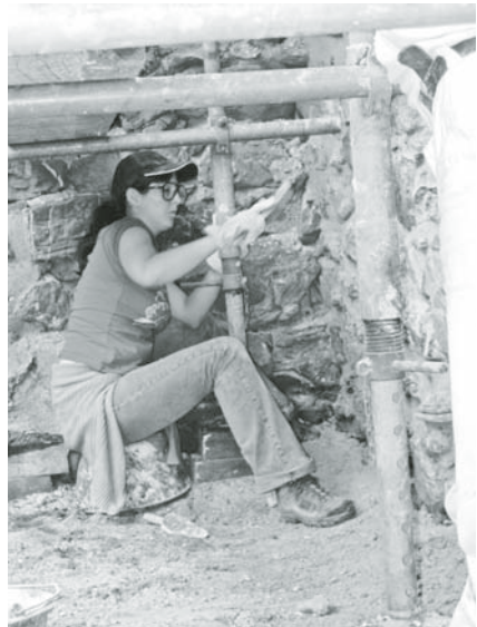
Unser Vorstandsmitglied Isabelle Finsterwald bei der Nachbearbeitung von frisch ausgeworfenem Mauerwerk in der NW-Ecke. P. S. Ihre Brille geht nicht nach der Mode, sondern erfüllt einfach Sicherheitsanforderungen. (Foto BVG)
