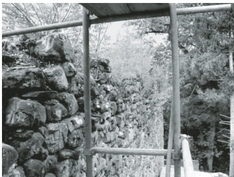
Mauerkrone im Vorzustand (Foto BVG)
